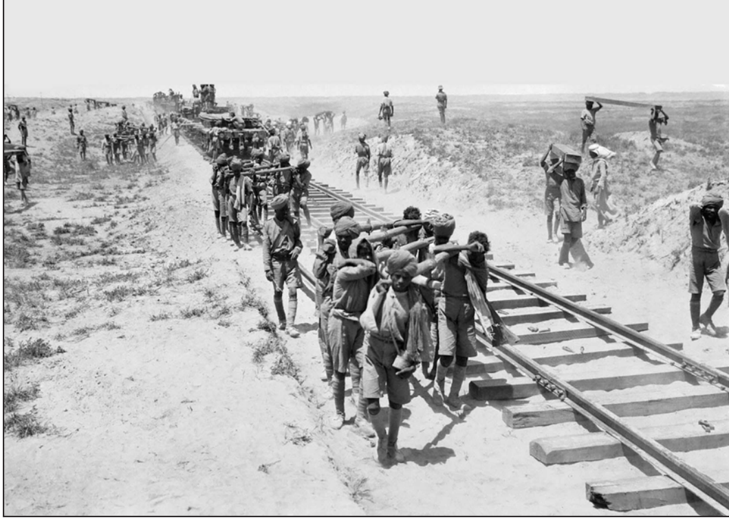
Shaikh Saad'dan İmam al-Mansur'a kadar uzanan dekovil hattının inşası.
