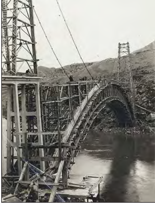
Tunceli, Singeç Köprüsü inşaatı.
